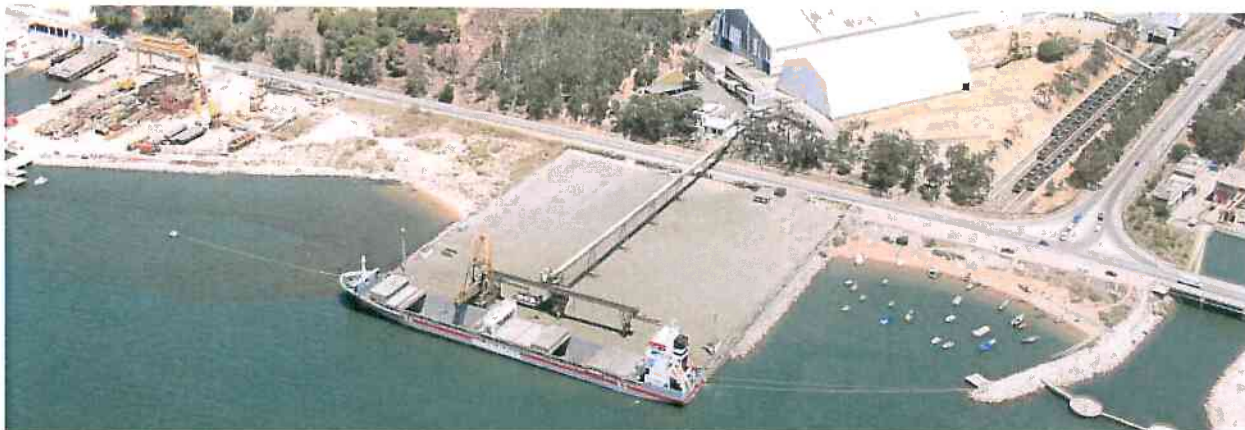
Terminal de Praias do Sado. (Fig. 6)
