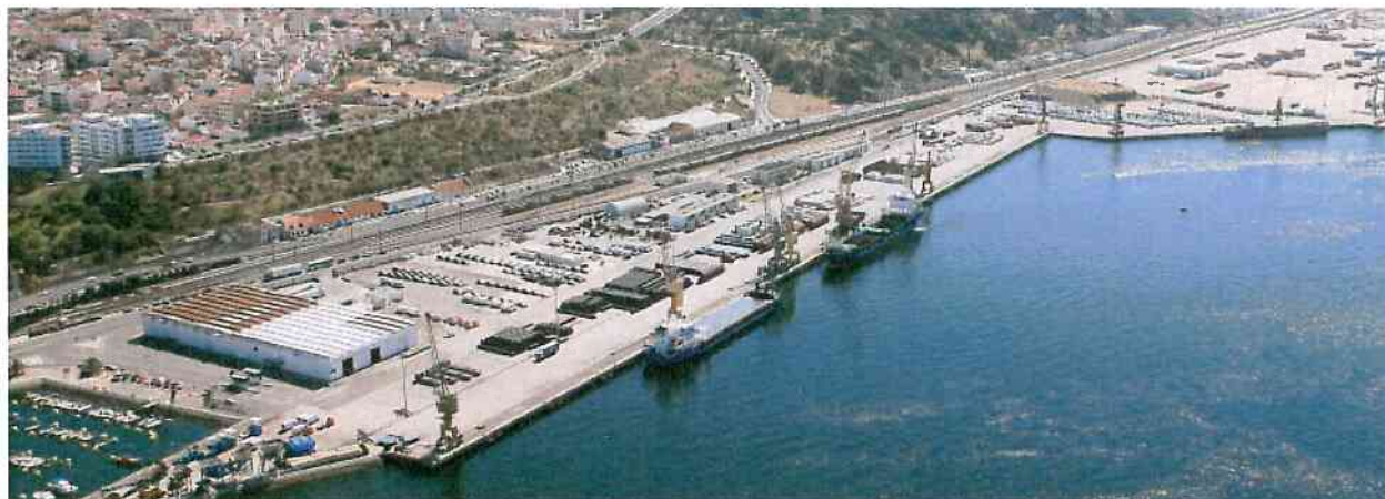
Terminal Multiusos – Zona 1. Tersado. (Fig. 3)
